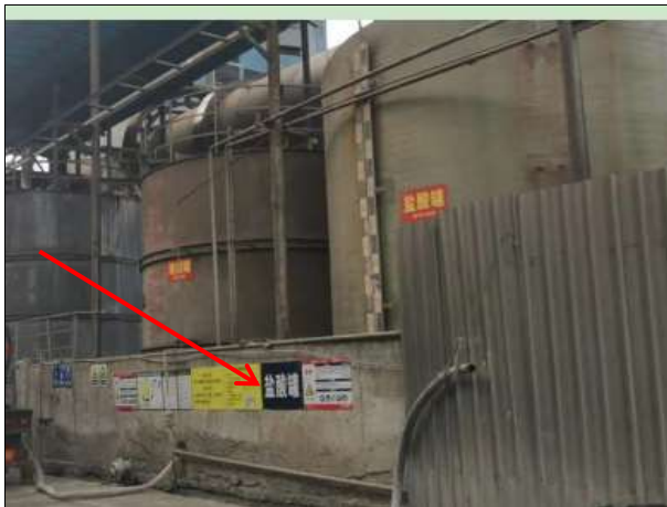
盐酸、氢氧化钠储罐围堰
