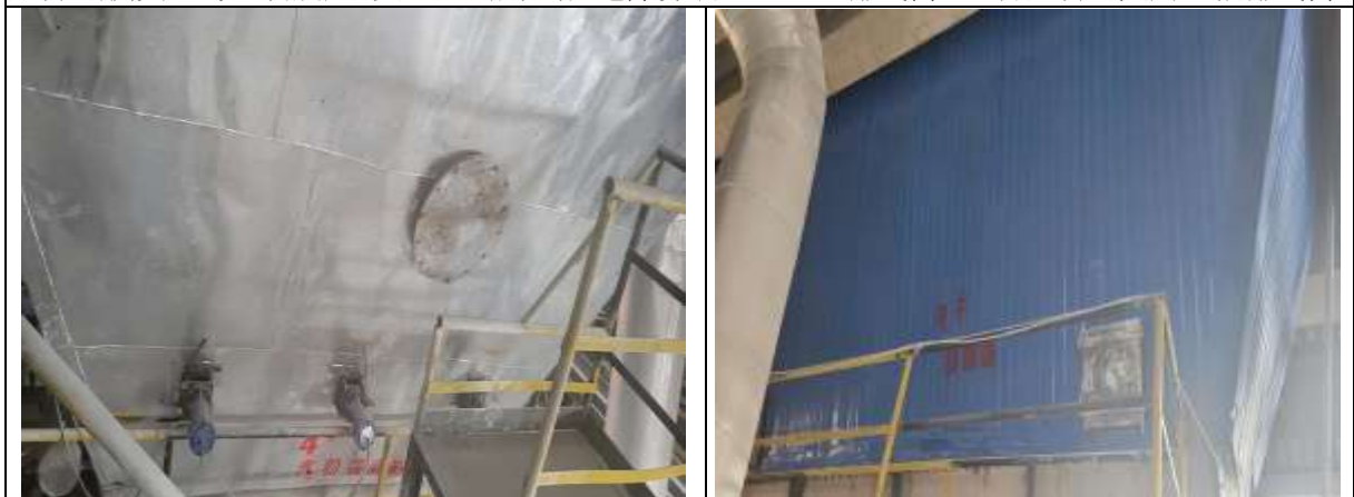
闪蒸干燥尾气“3 台袋式除尘器”+15m 排气筒（3 套闪蒸干燥机共用一根排气筒）
