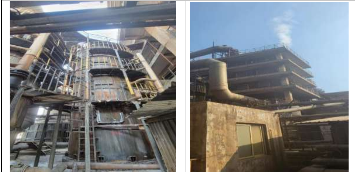
回转窑煅烧尾气“2 套旋风+文丘里+碱洗塔+电除雾装置”+60m 排气筒（2 台回转窑共用一根排气筒）
