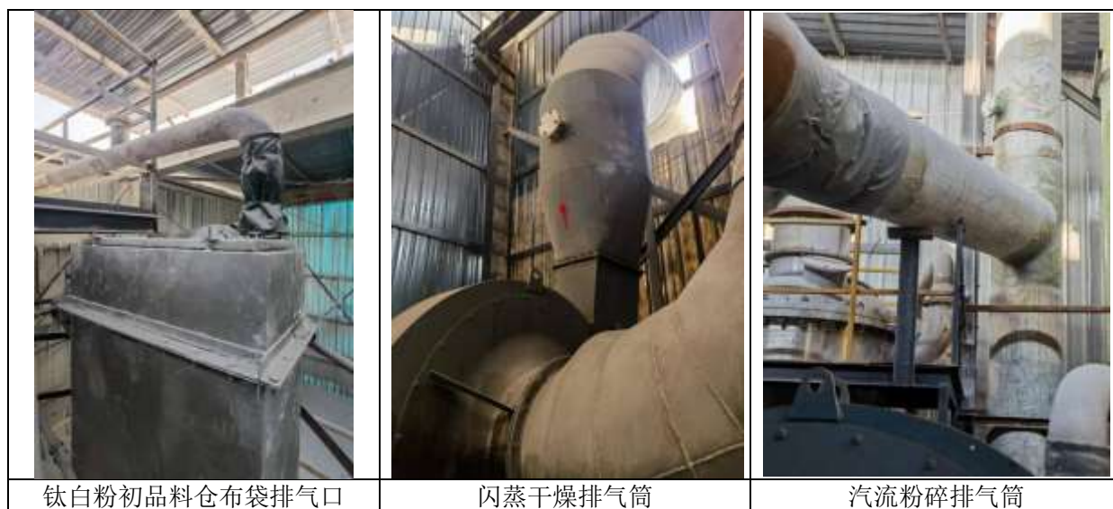
图 2.3-2 钛白粉后处理（包膜）生产线主要环保设施现状
