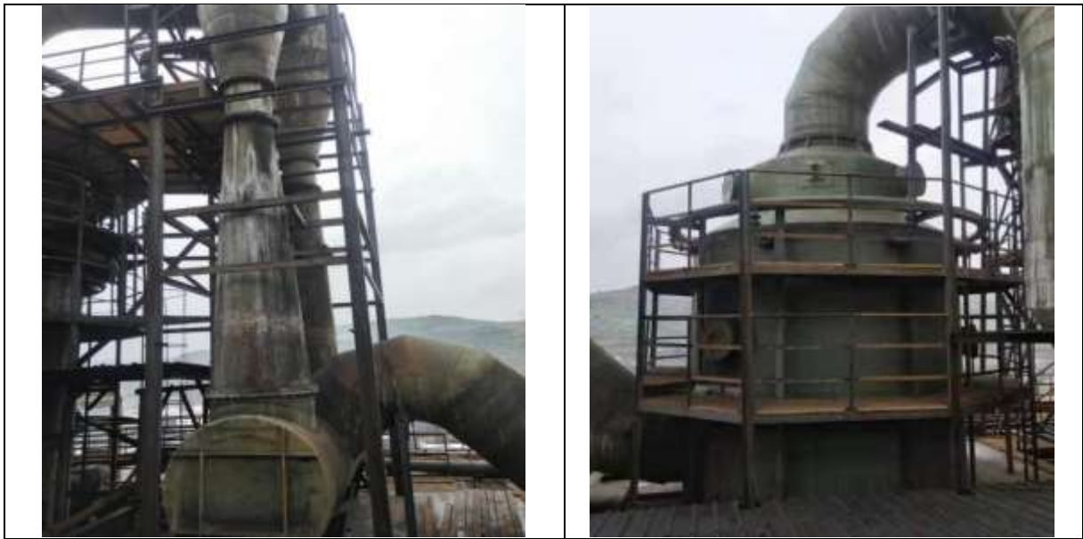
酸解尾气“一级水洗+文丘里+两级碱洗脱硫除雾”+40m 排气筒
