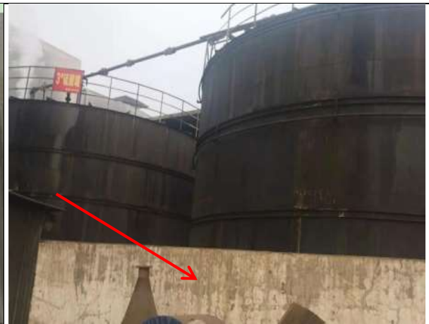
硫酸储罐围堰
