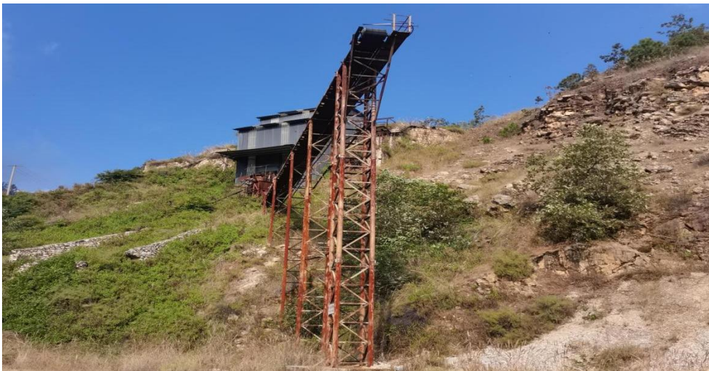
图 3-7 矿区破碎站现状图
