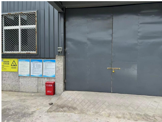
危废暂存间外
