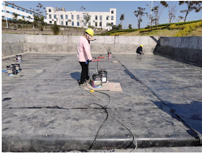
危废暂存间防渗层施工
