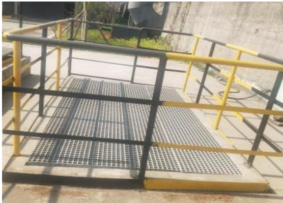
一次铤清洗机和坩埚清洗废水沉淀池
