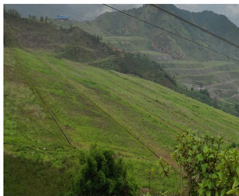
尾矿库堆积坝及绿化
