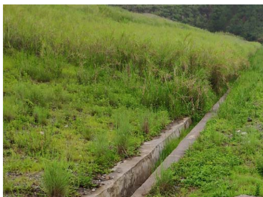
尾矿库马道排水沟
