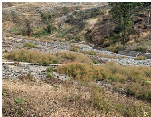
尾矿库初期坝
