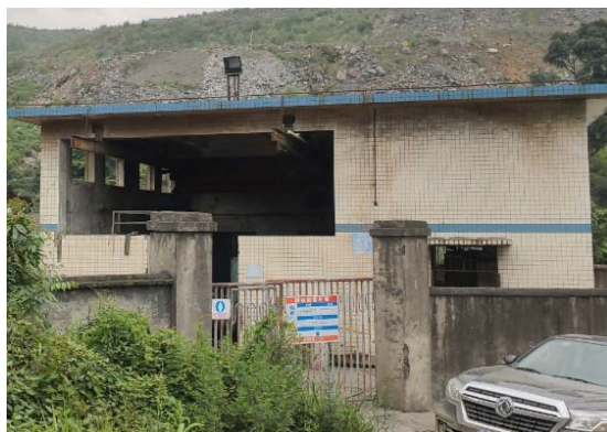
尾矿库渗滤水加压泵站
