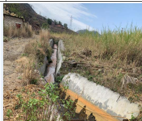
尾矿库坝肩截洪沟
