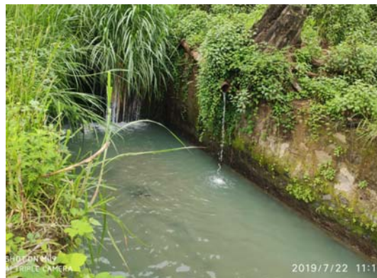
尾矿库渗滤水收集池
