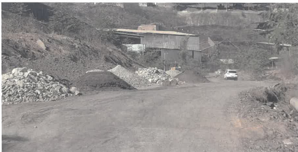
钛联 1 号公路堆放的硬化道路材料
