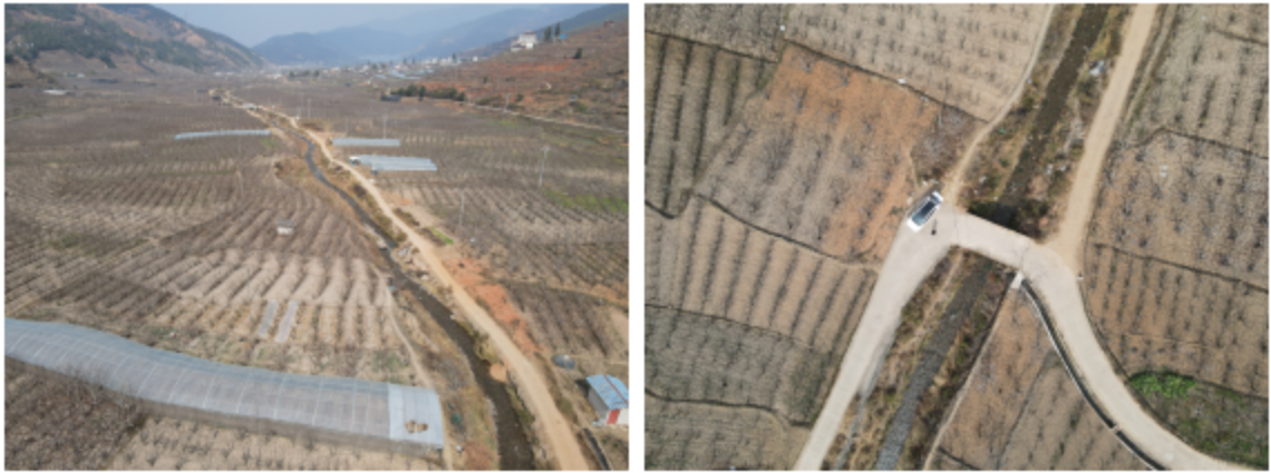
工程拟建堤防段（下段）照片
