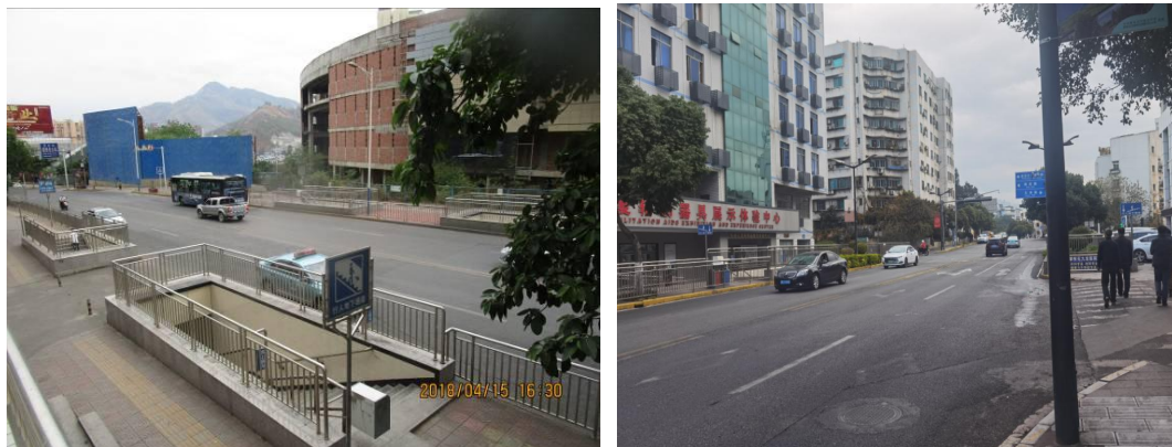
图 3-5 地下通道出入口未设置雨篷
