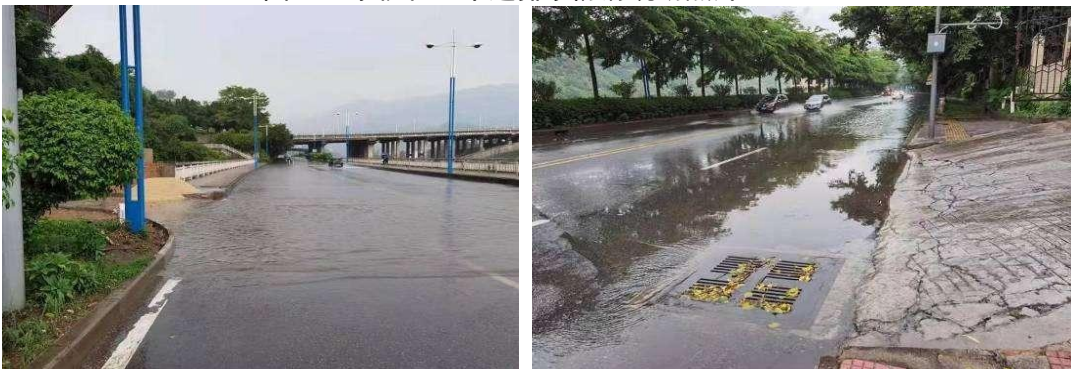
图 3-4 攀枝花主干道排水防涝现场照片（2）
