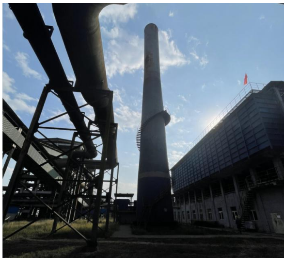
烧结机尾、环冷机一二次混合废气
