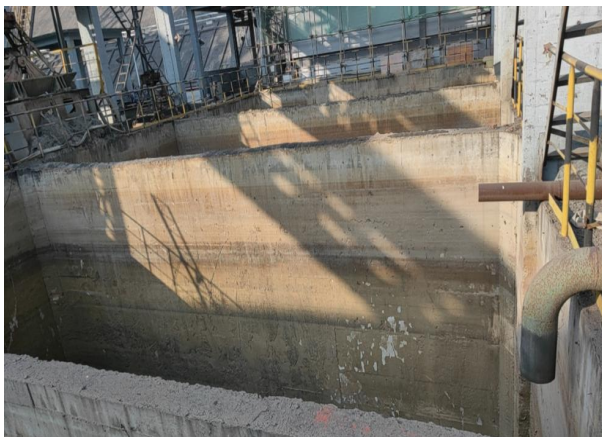
炼铁车间冲渣池
