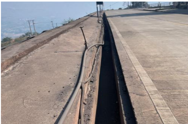
厂区雨水管沟
