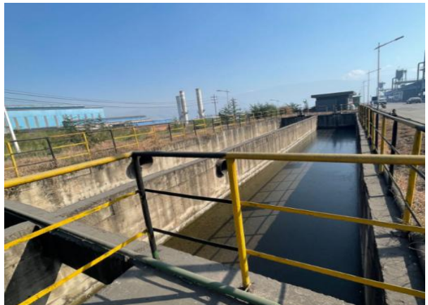
原料场初期雨水池
