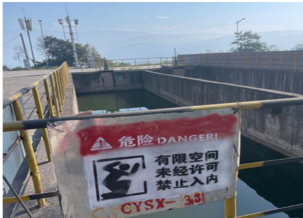
原料场初期雨水池
