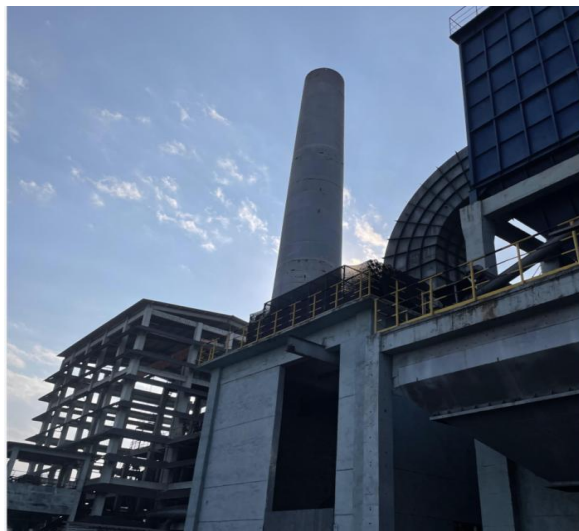
炼铁 1#矿槽及上料粉尘（暂未复产）
