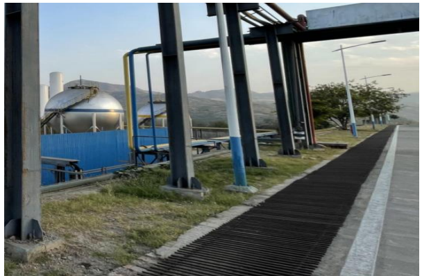
厂区雨水管沟
