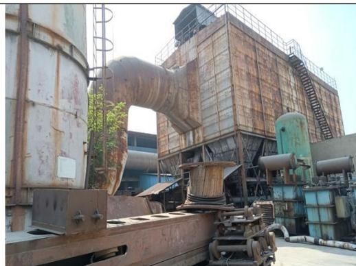
熔炼工序旋风+布袋除尘器
