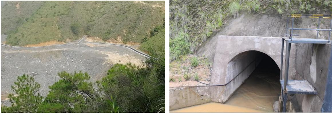
图 3.1-8 热水塘排土场周边截洪沟、排洪隧洞入口
