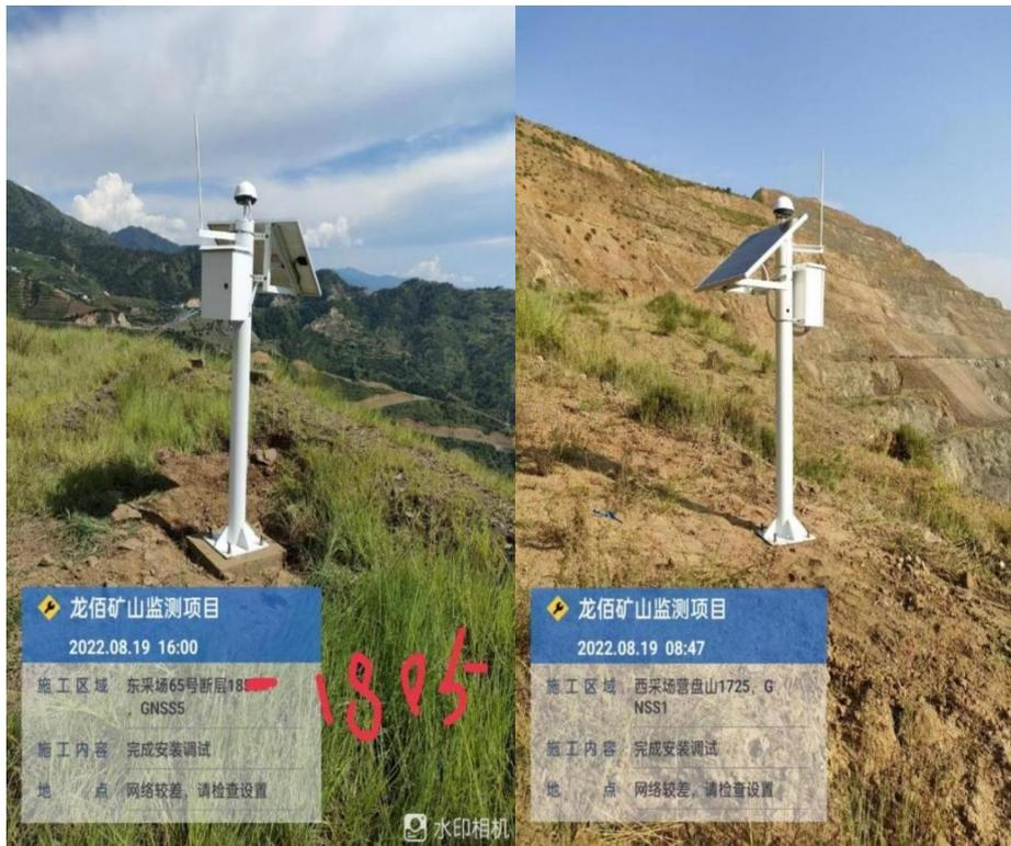
图 2.4-8 表面位移监测站现场照片
