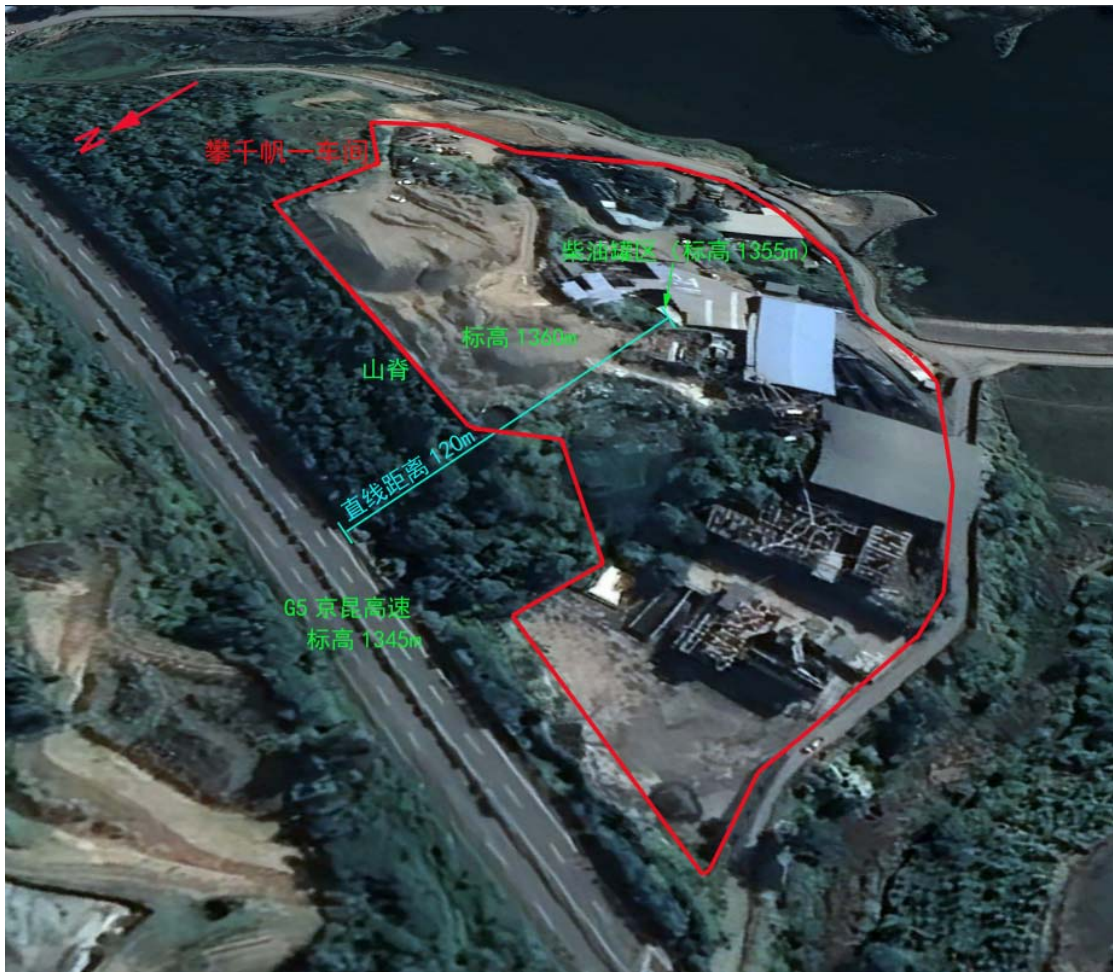
攀千帆一车间柴油罐区与 G5 京昆高速公路位置关系图
