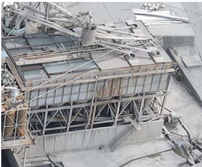
攀千帆一车间斜板浓缩池
