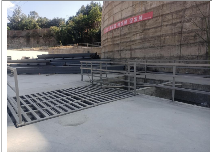
运输扬尘处理措施 (车辆冲洗平台)
