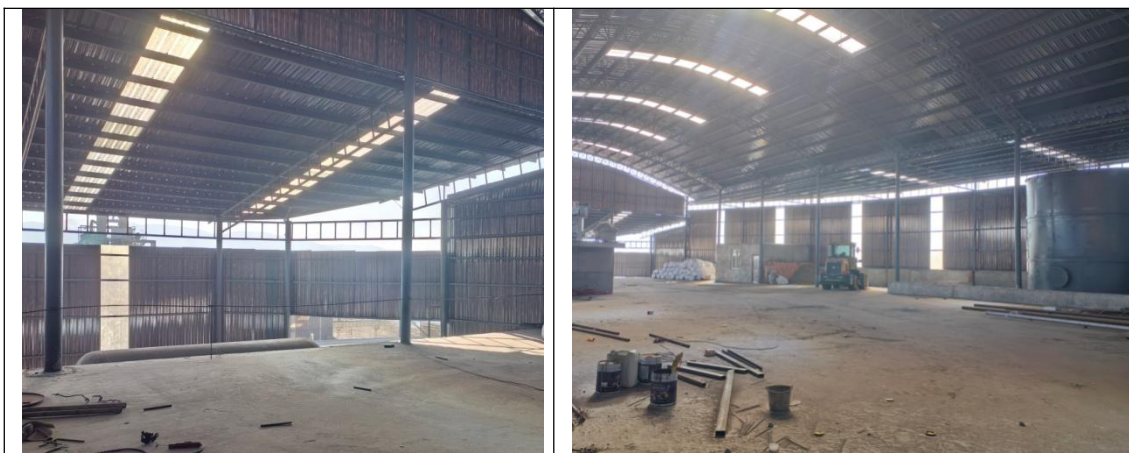
图 1.5-1 厂房内部现状
