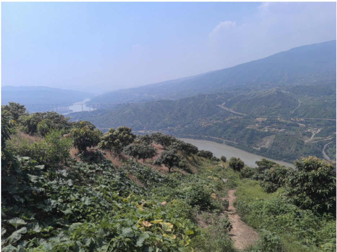
图 3-4 N22-N32 塔基区域现状代表照片
