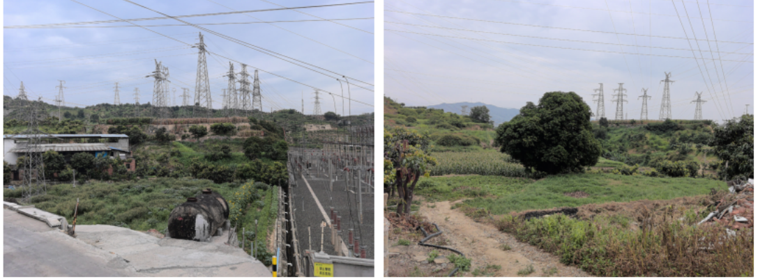
图 3-2 青龙山变电站区域 (N35-N36 地理线路段) 现状代表照片
