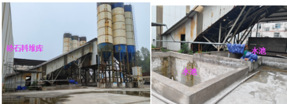
十九冶年产 10 万立方混凝土项目场地（现状）
