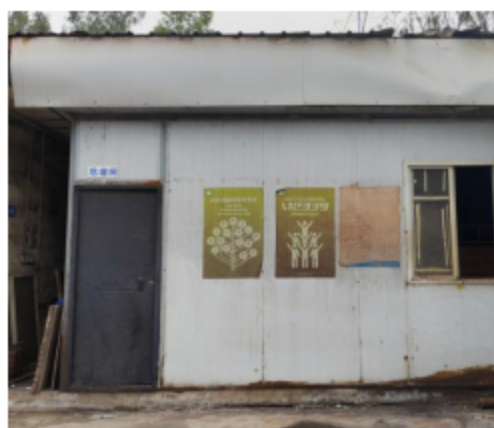
危废暂存间（现状）
