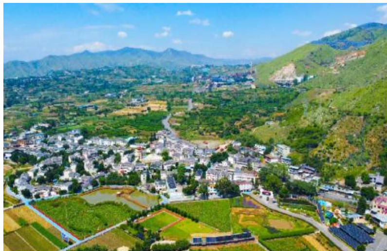
图 1 昔格达零碳示范村全貌
