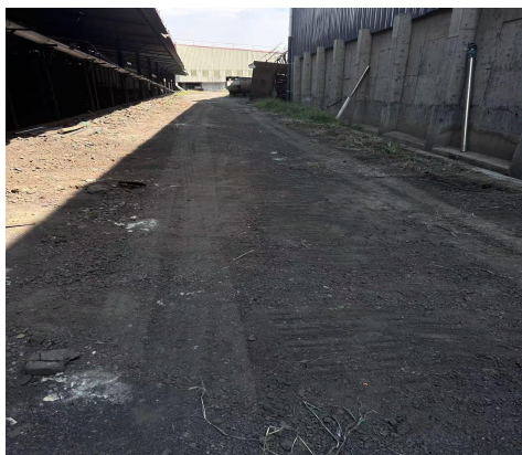
图 2-7 现有未硬化路面
