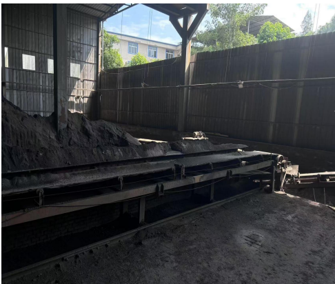
图 2-10 现有车间未全封闭
