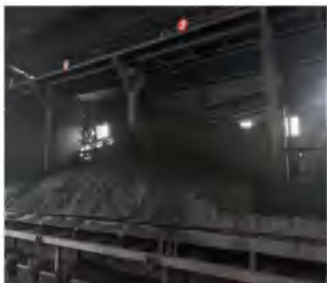
图 2-9 现有陈化库喷洒损坏
