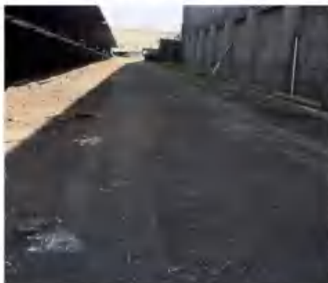
图 2-7 现有未硬化路面
