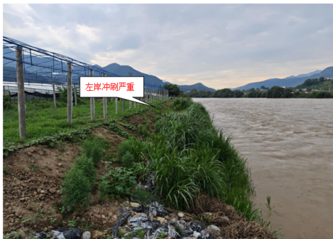
图 3-4 安宁河麻窝段左岸现状图
