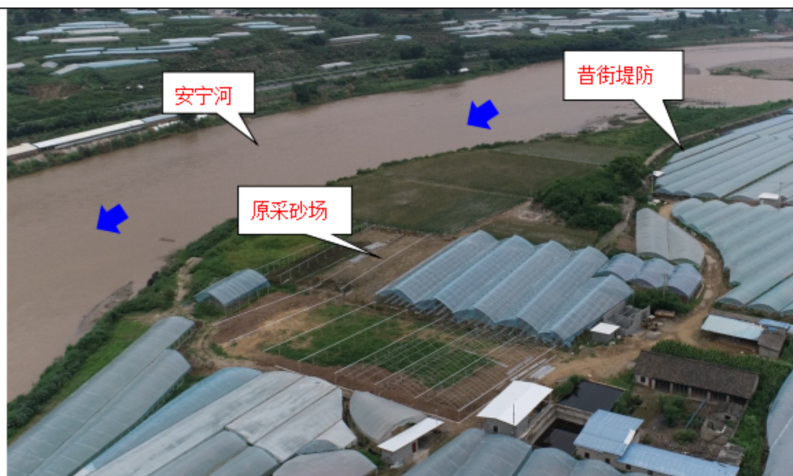
图 3-3 安宁河麻窝段左岸河道起点现状图
