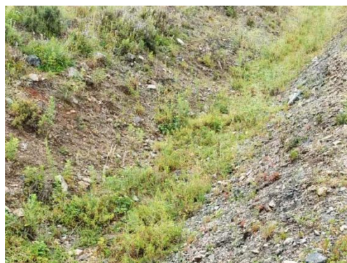
排土场平台排洪沟现状图
