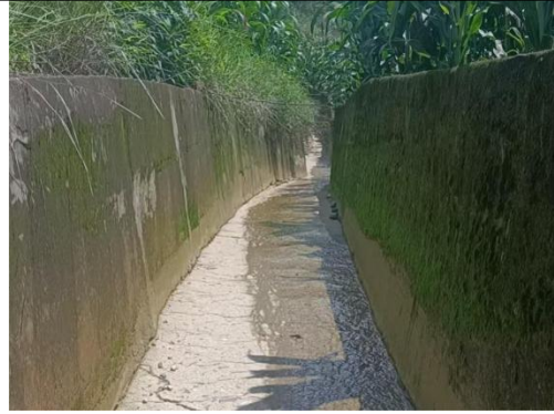
1#排土场左坝肩截洪沟现状图
