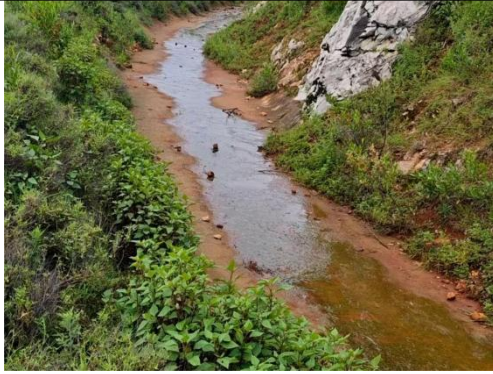
2#排土场右坝肩截洪沟现状图
