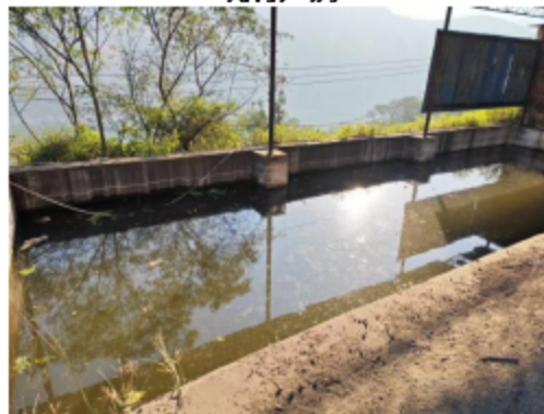
现有循环水池
