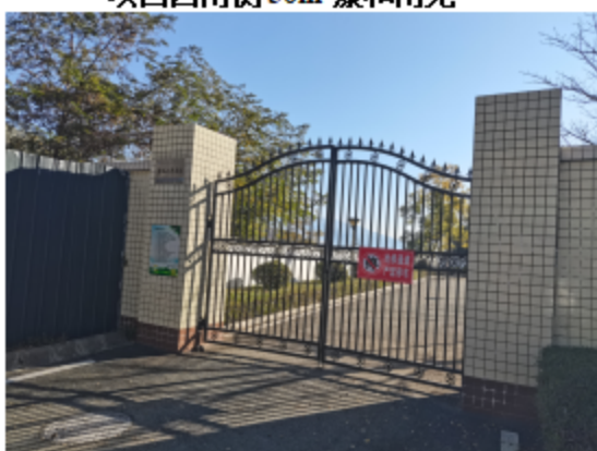
项目西南侧紧邻普达 2 号泵站
