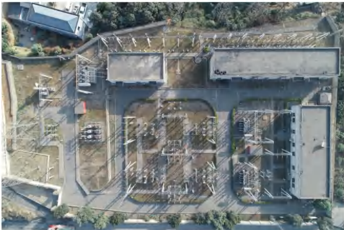
图 3-2 已建城南 110kV 变电站现状
