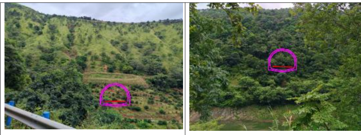
图 2-16 鲢鱼隧道进出口地貌
