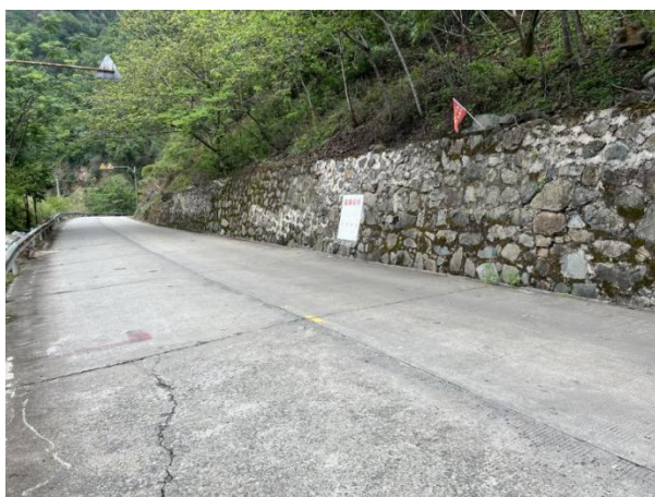
浆砌片石路堑墙
